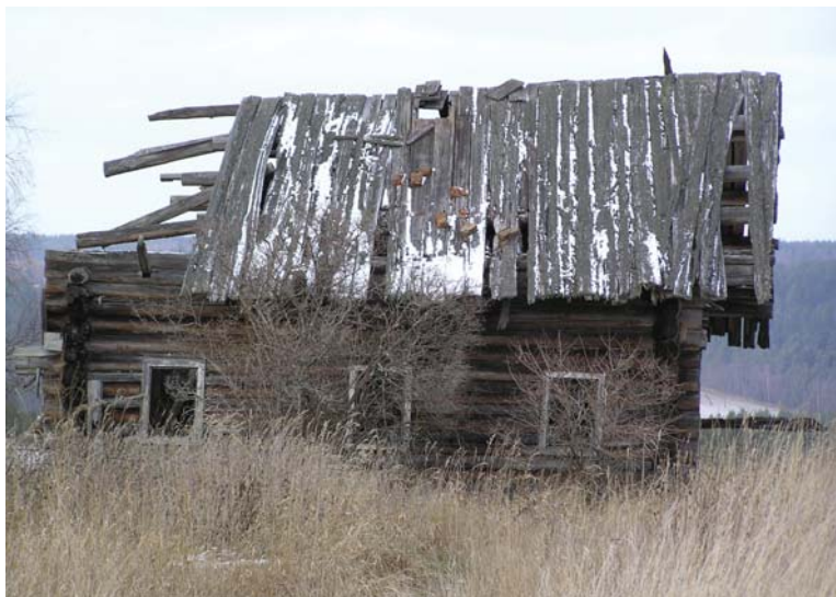
Рис. 2. Разрушенная баня и хозяйстройки
